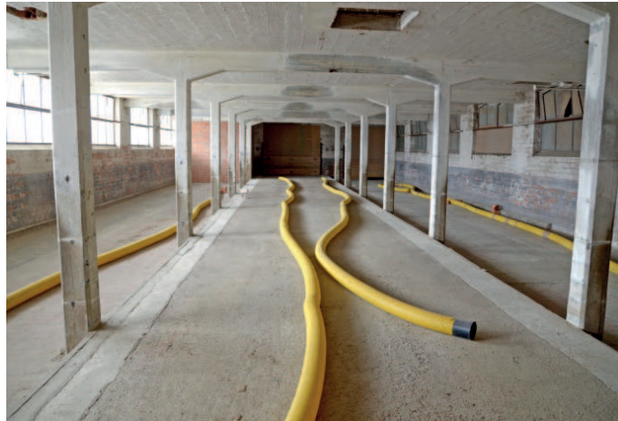
Leerstehende Wirtschaftsgebäude: Wenn die landwirtschaftliche Nutzung ruht, verbleibt das Gebäude trotzdem in der Grundsteuer A.
